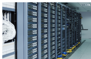
不间断电源系统 (UPS)
