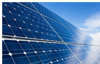
光伏发电系统
